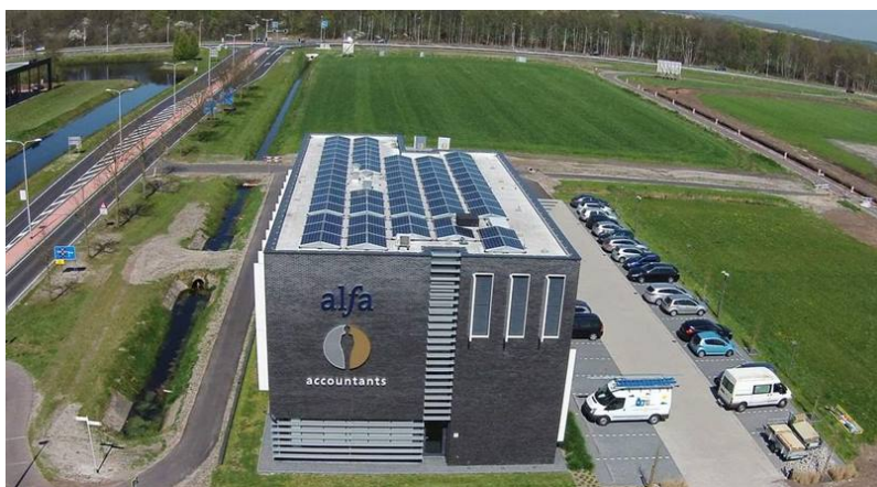
Zonnepanelen op het dak van het pand van Alfa Nijverdal
